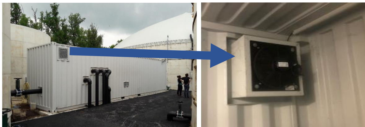
Figure 20 Représentation de la ventilation du Local process
